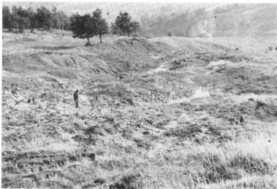
Fig. 24 - Smottamenti nelle « argille scagliose » presso Balze di Verghereto
